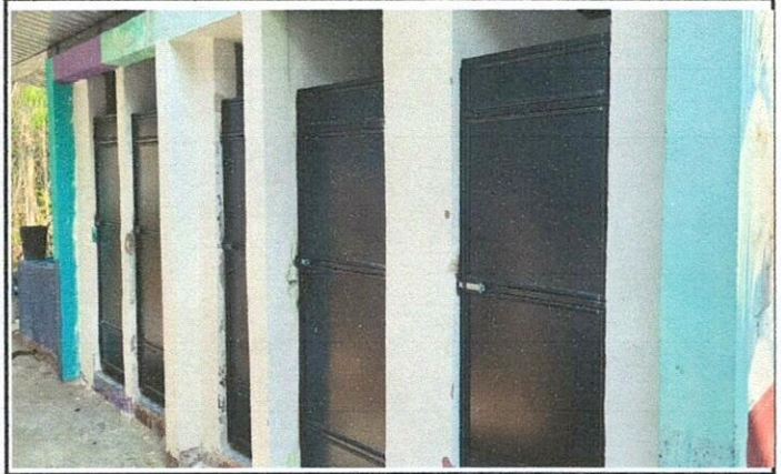
Foto 2: MEJORAMIENTO DE MODULO DE BAÑOS
