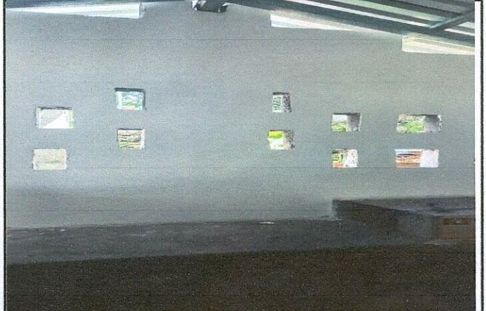
Foto 4: MEJORAMIENTO DE TECHO Y VENTANAL COCINA
