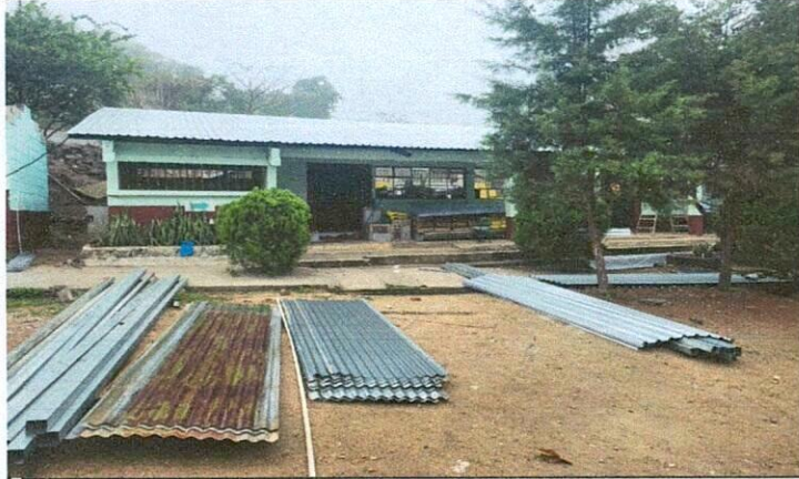
Foto 1: MEJORAMIENTO DE TECHO DE AULAS
