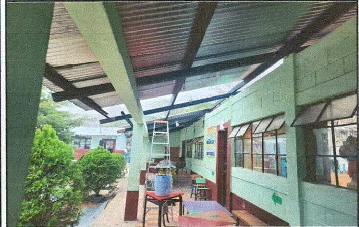
Foto 4: MEJORAMIENTO DE AULA, VENTANAL
