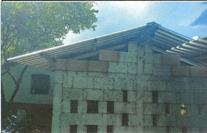
Foto 3: MEJORAMIENTO DE TECHO Y VENTANAL COCINA
