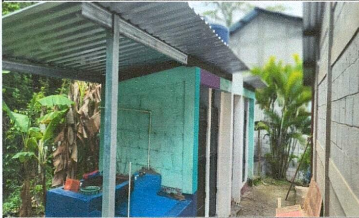
Foto 1: MEJORAMIENTO DEMODULO DE BAÑOS
